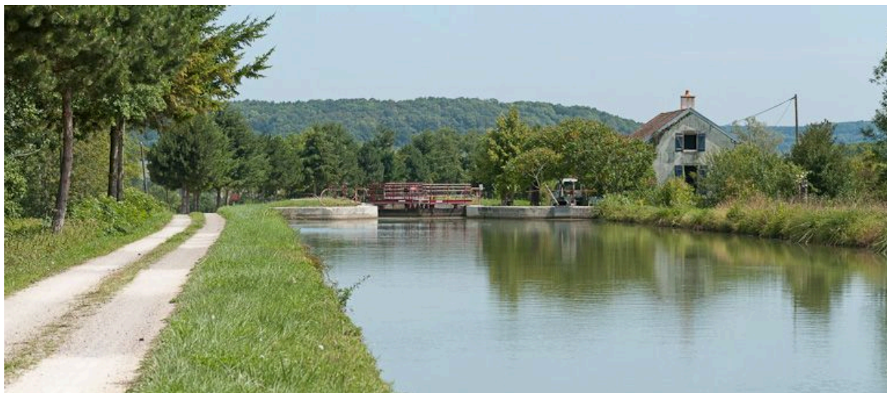
Vue du site d'écluse en amont.
