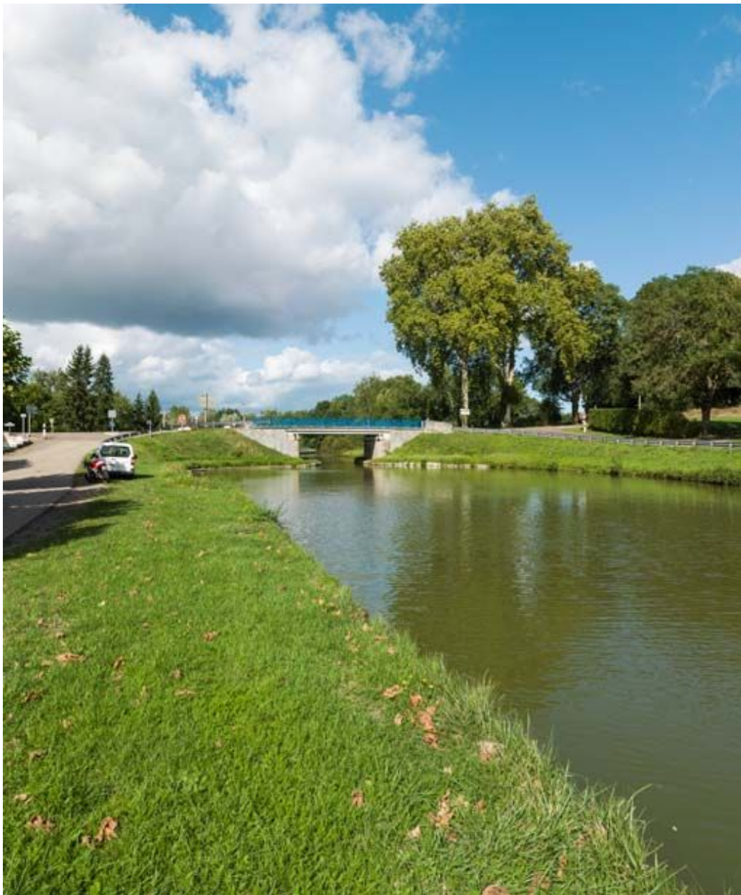
Vue d'ensemble du pont.
