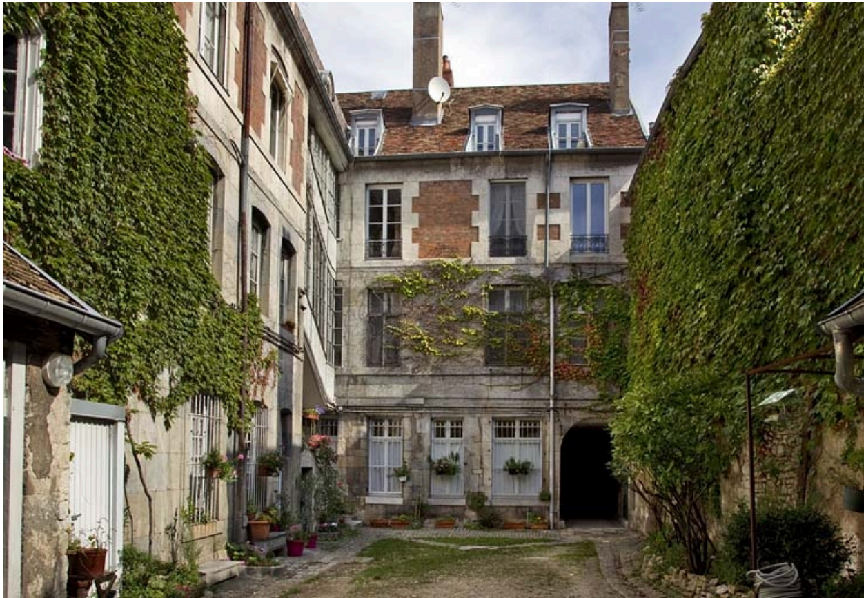
Logis principal, façade postérieure depuis le fond de la cour.
