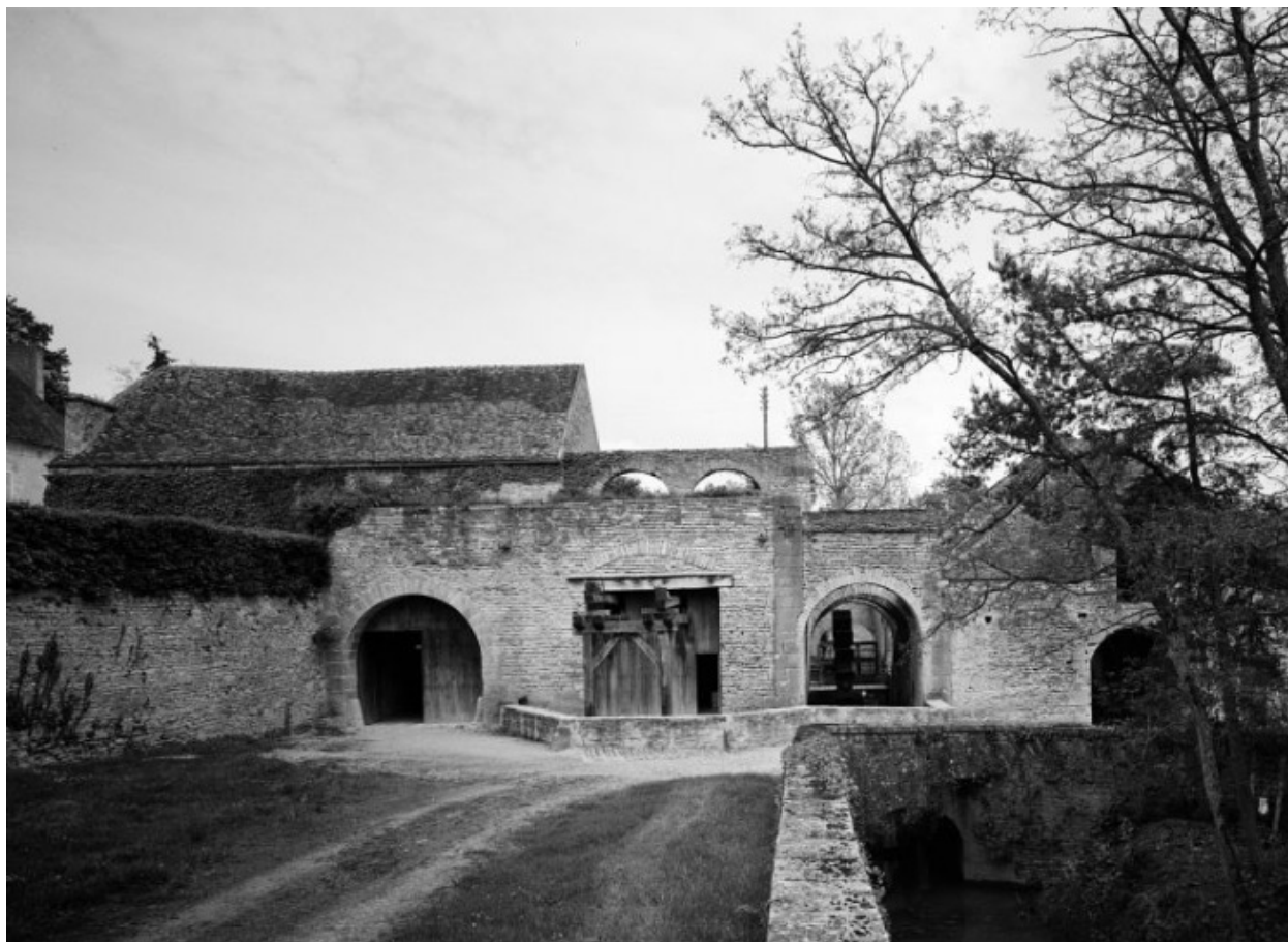
Elévation sud de l'usine prise de la rampe d'accès.
