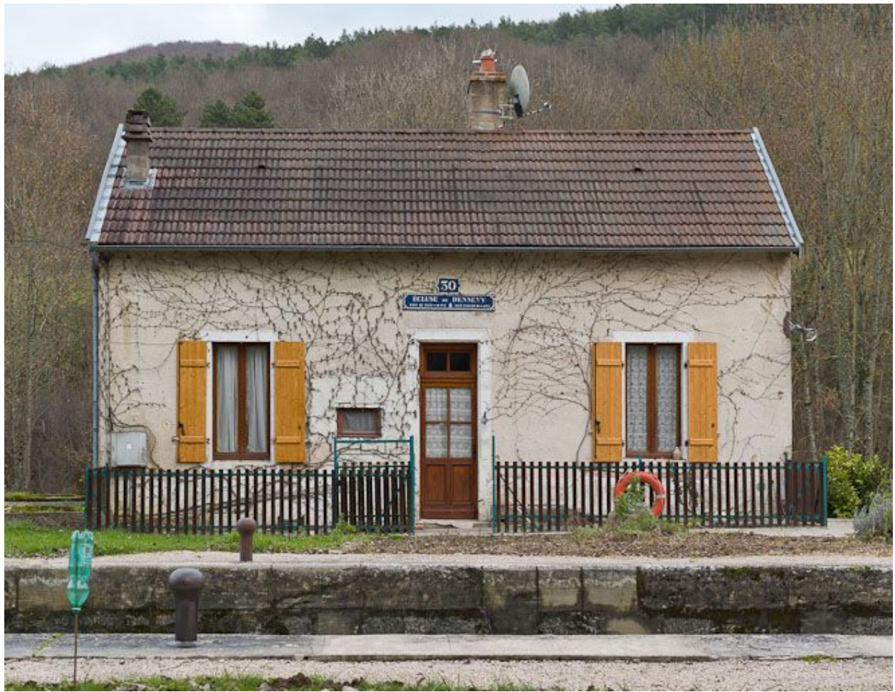
Vue de face de la maison éclusière.
