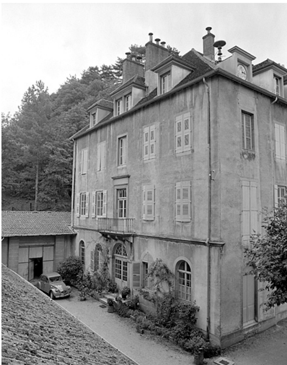
Façade antérieure du bâtiment C.
