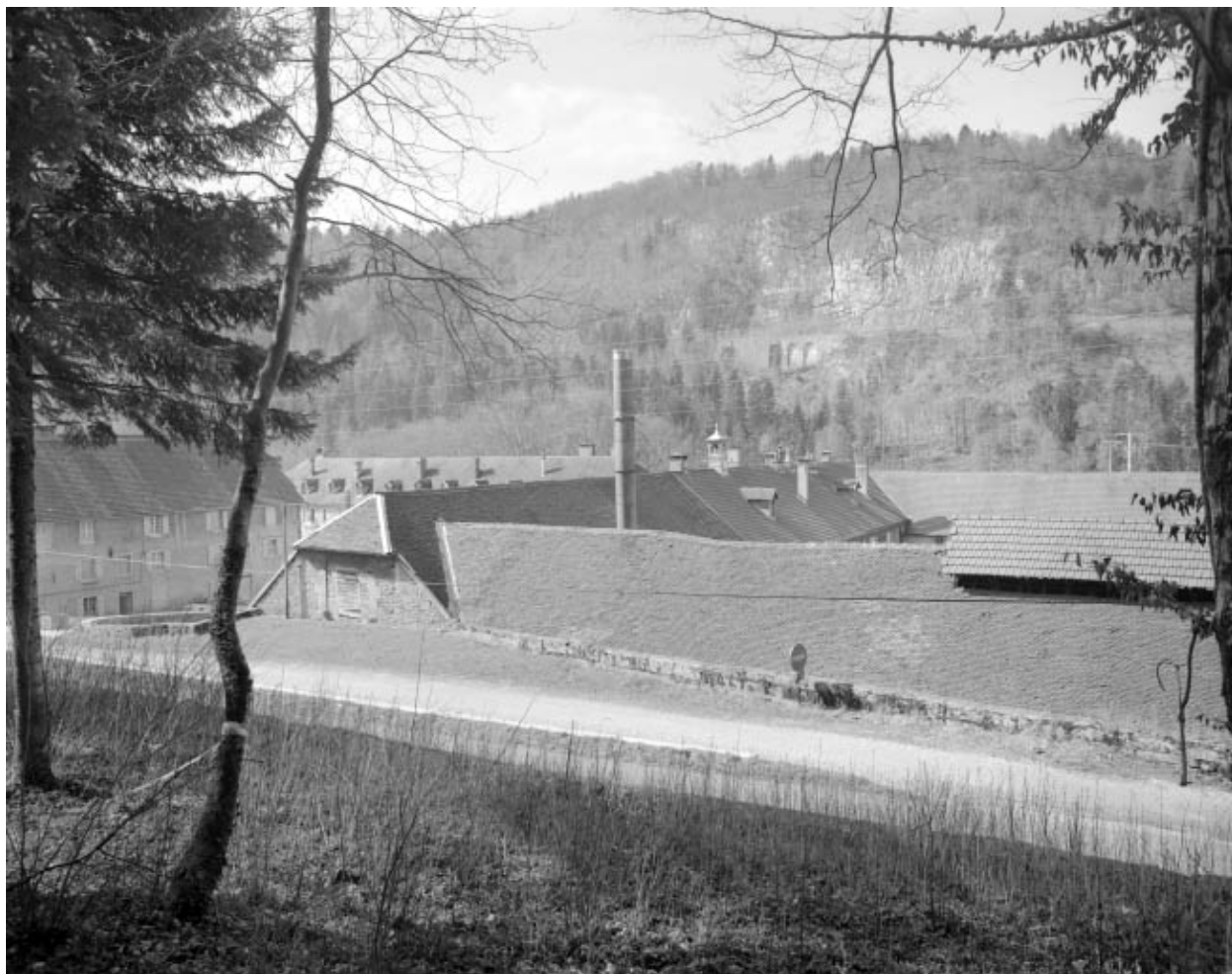
Façade sur rue de l'aile est.
