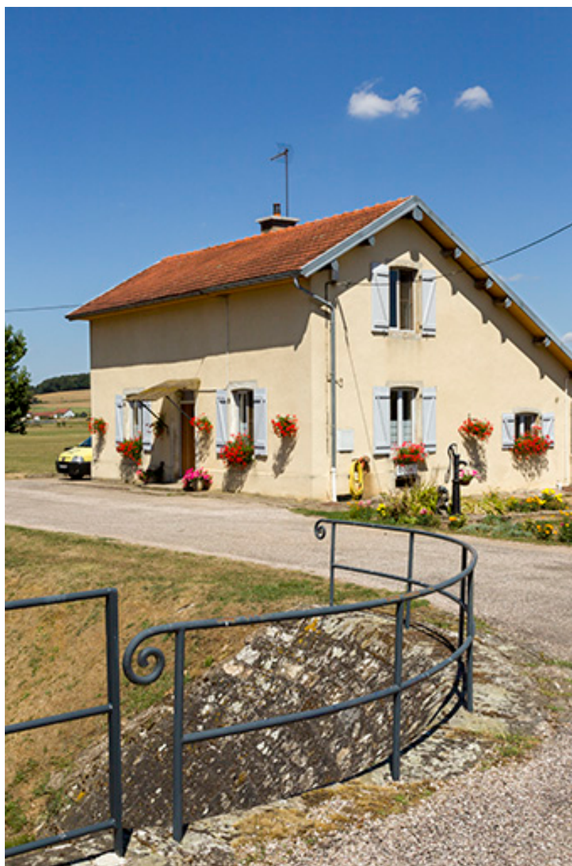
La maison, vue de profil.
