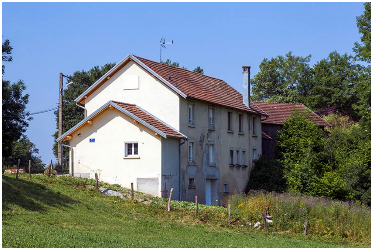
Façades postérieure et latérale droite.
