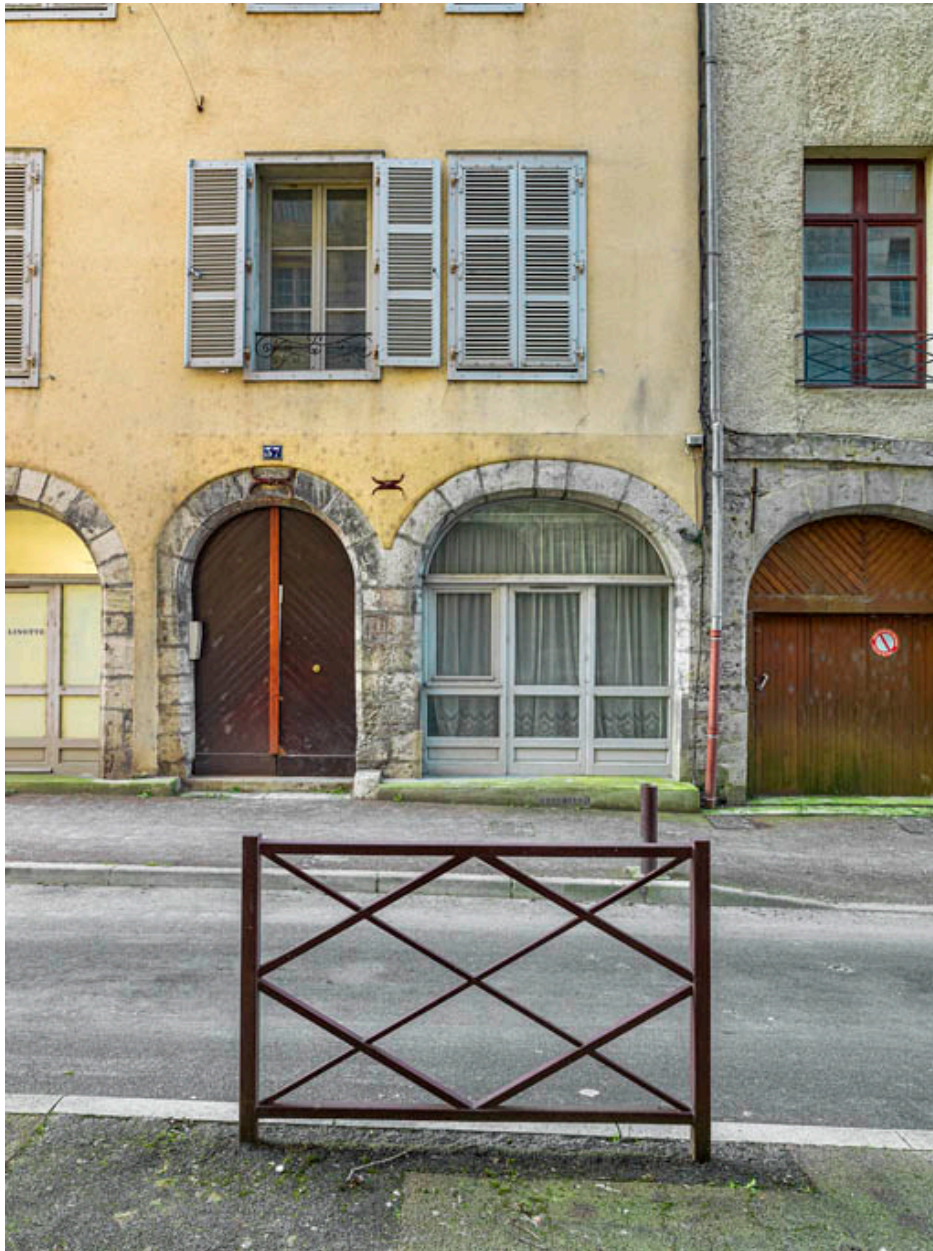
Façade antérieure du bâtiment sur rue. Partie nord.
