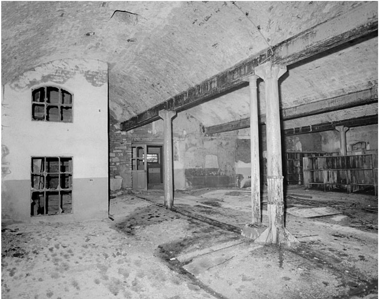
Premier étage, grande salle, côté ouest.
