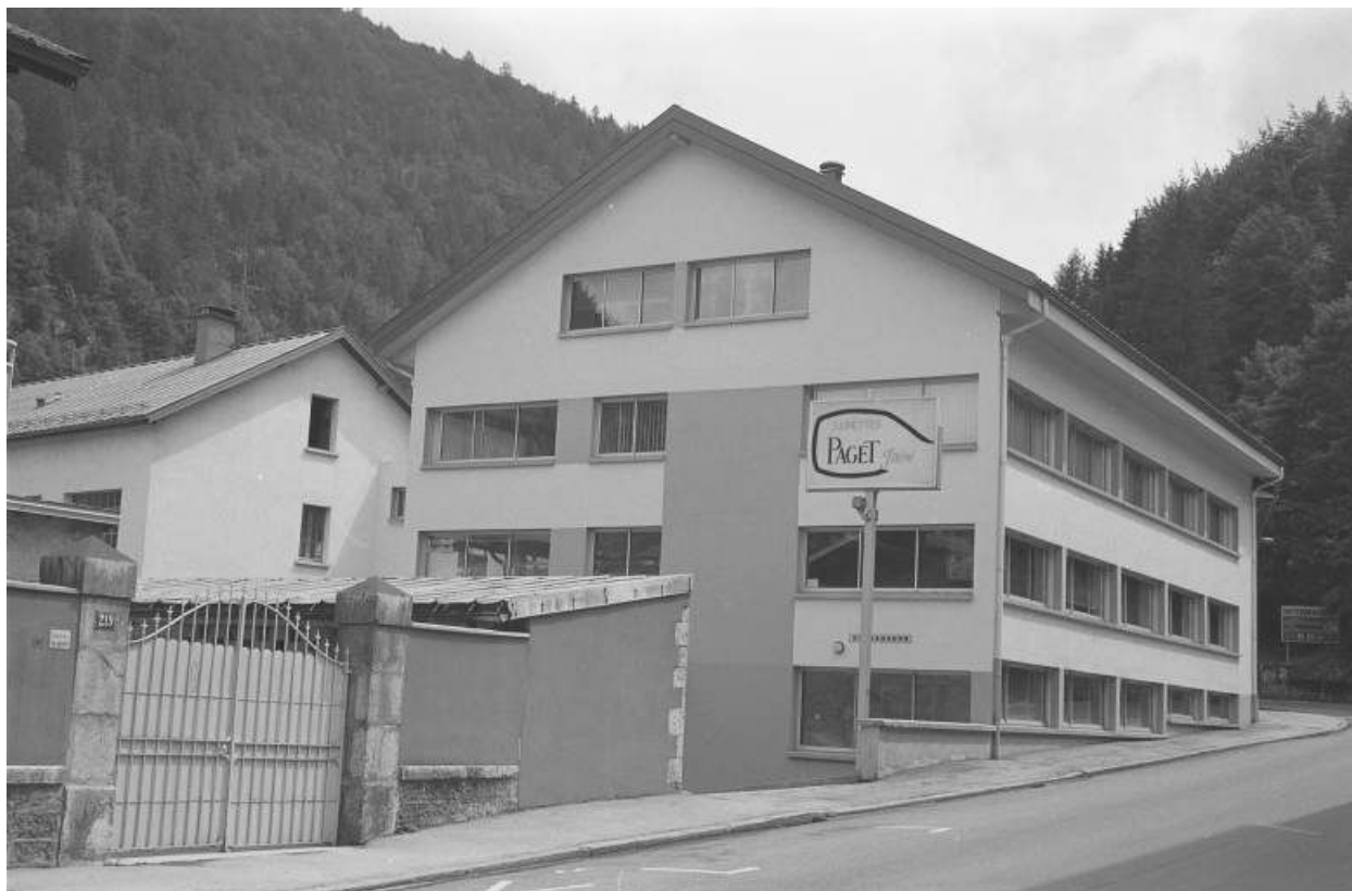
Façades postérieure et latérale droite des bureaux.
