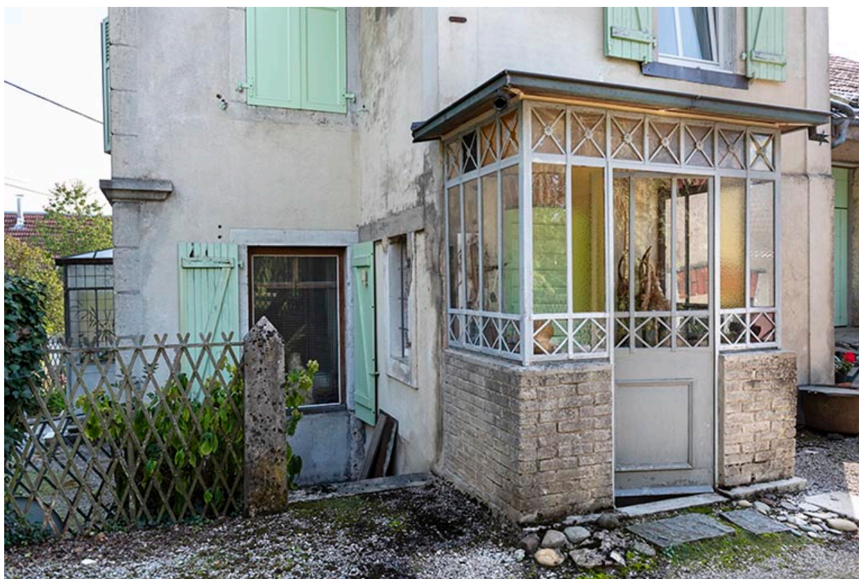
Logement Hugoniot : véranda nord, de trois quarts.
