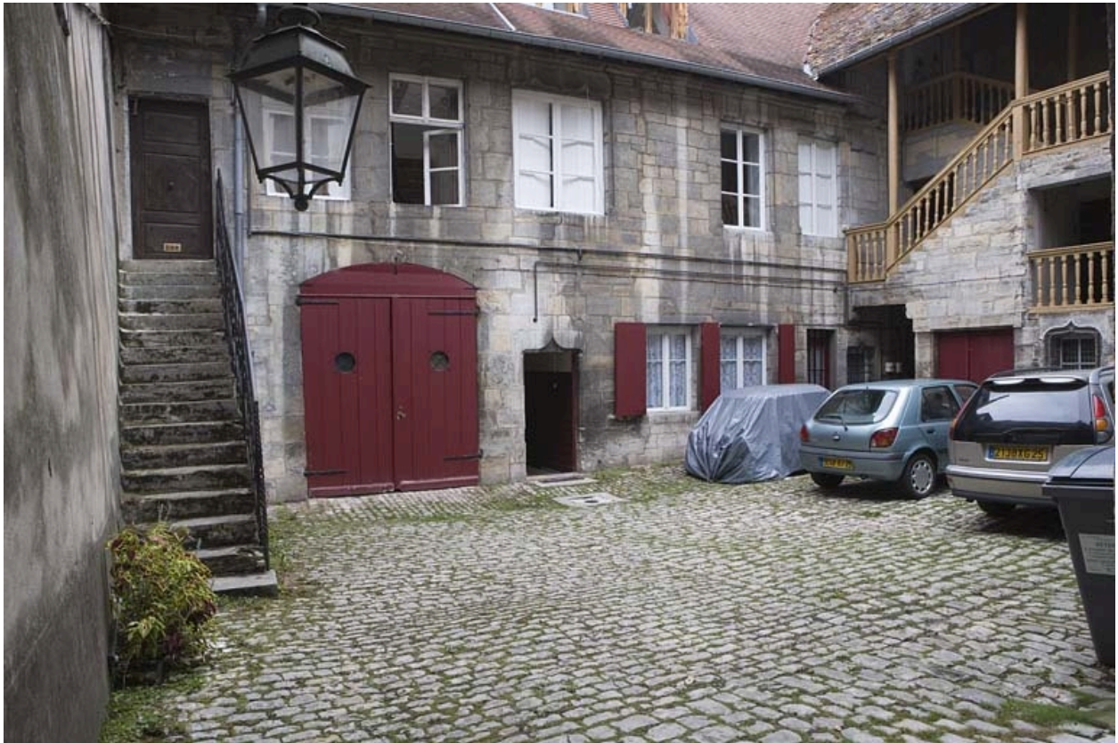
Vue d'ensemble du logis secondaire sur cour.
