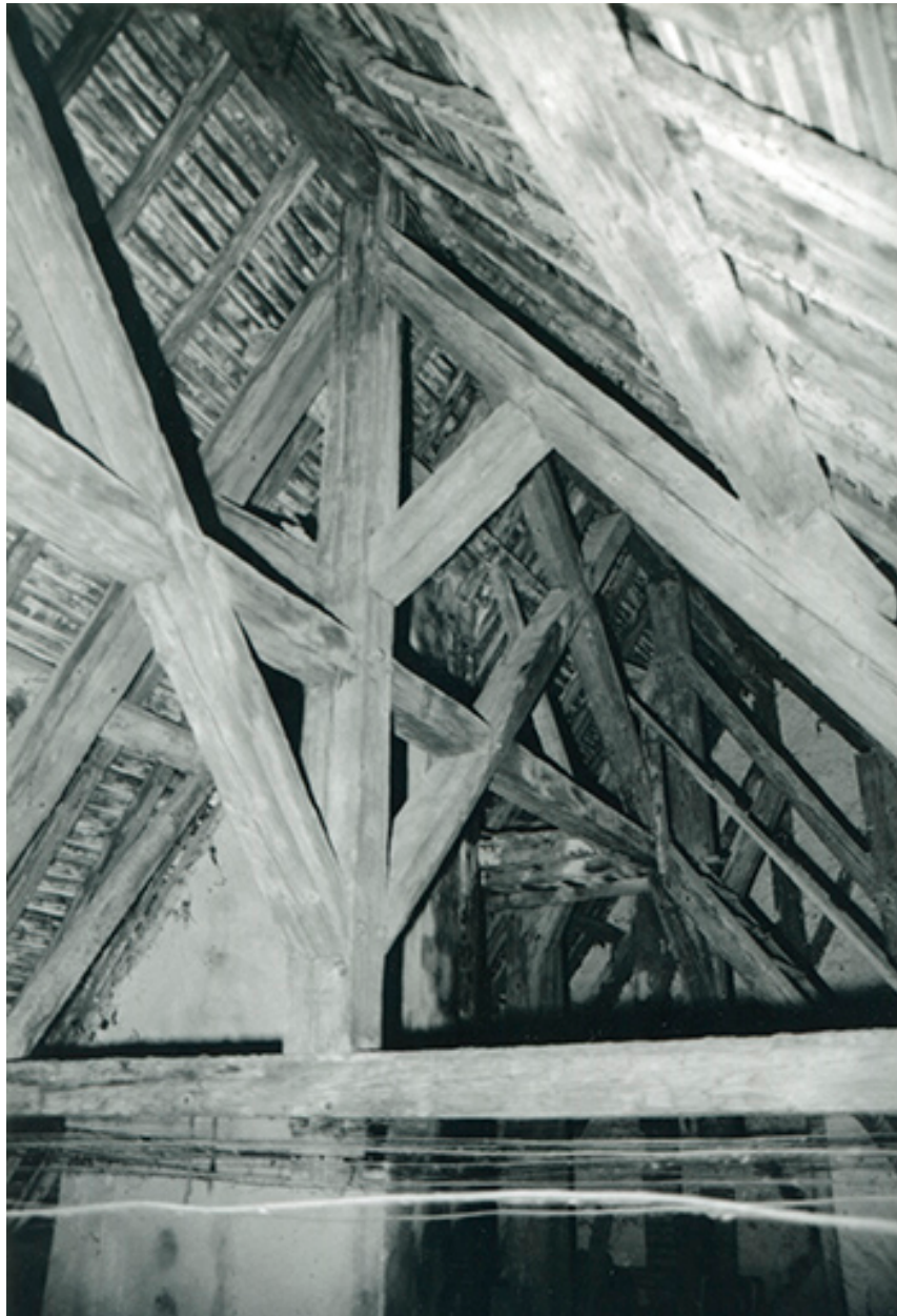
Charpente du bâtiment conventuel, 1997.
