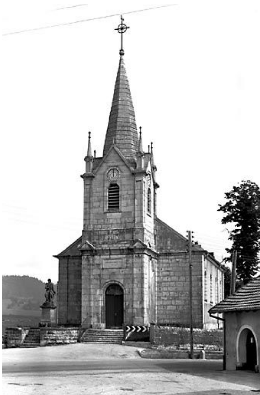
Façades antérieure et latérale droite.
