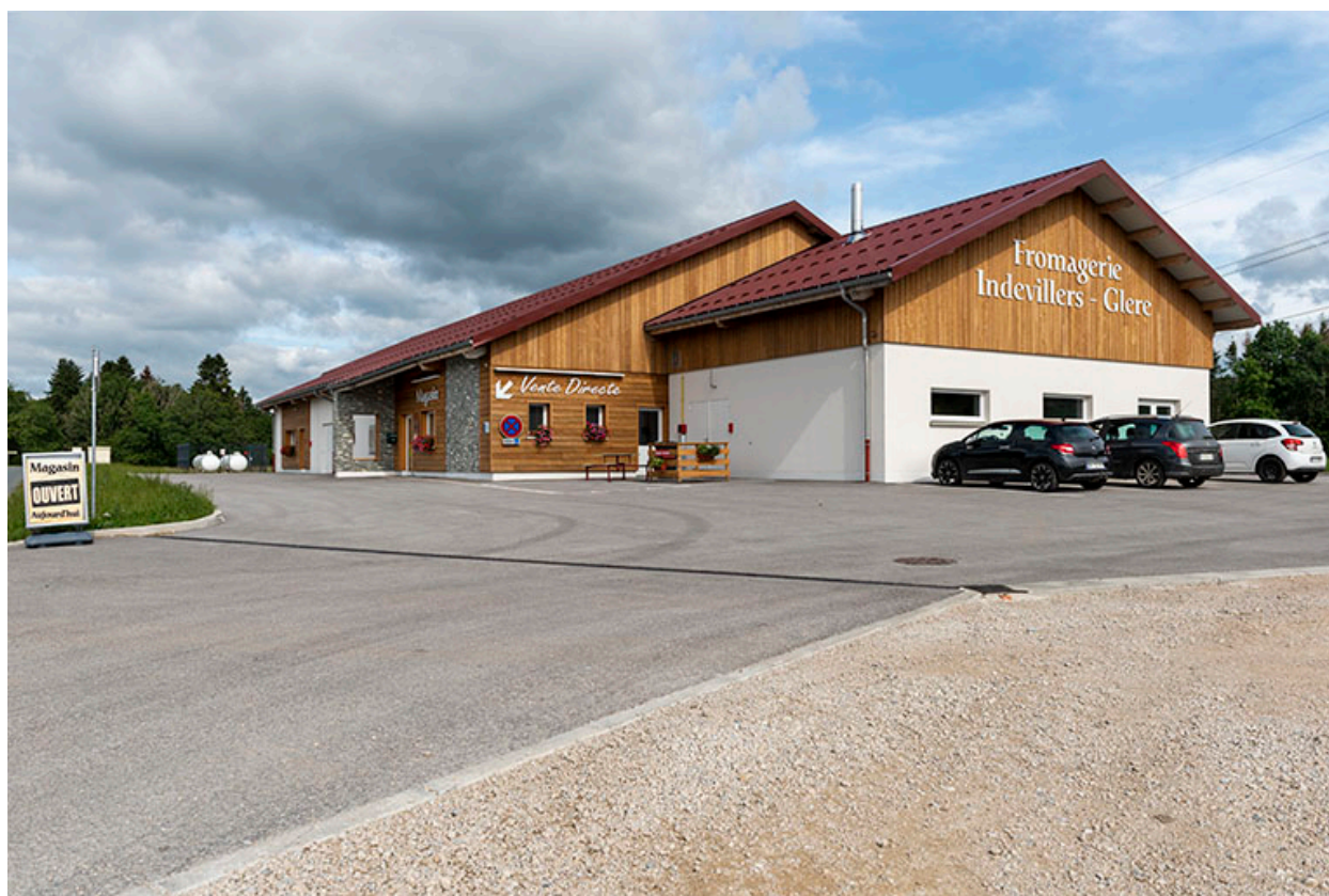
Façades antérieure et latérale droite.
