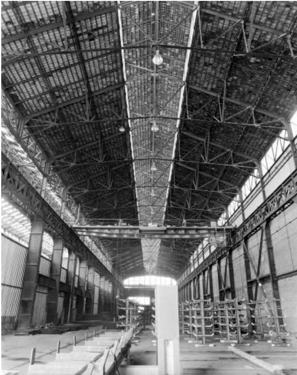
Vue intérieure de la halle centrale de l'aciérie en 1981.
