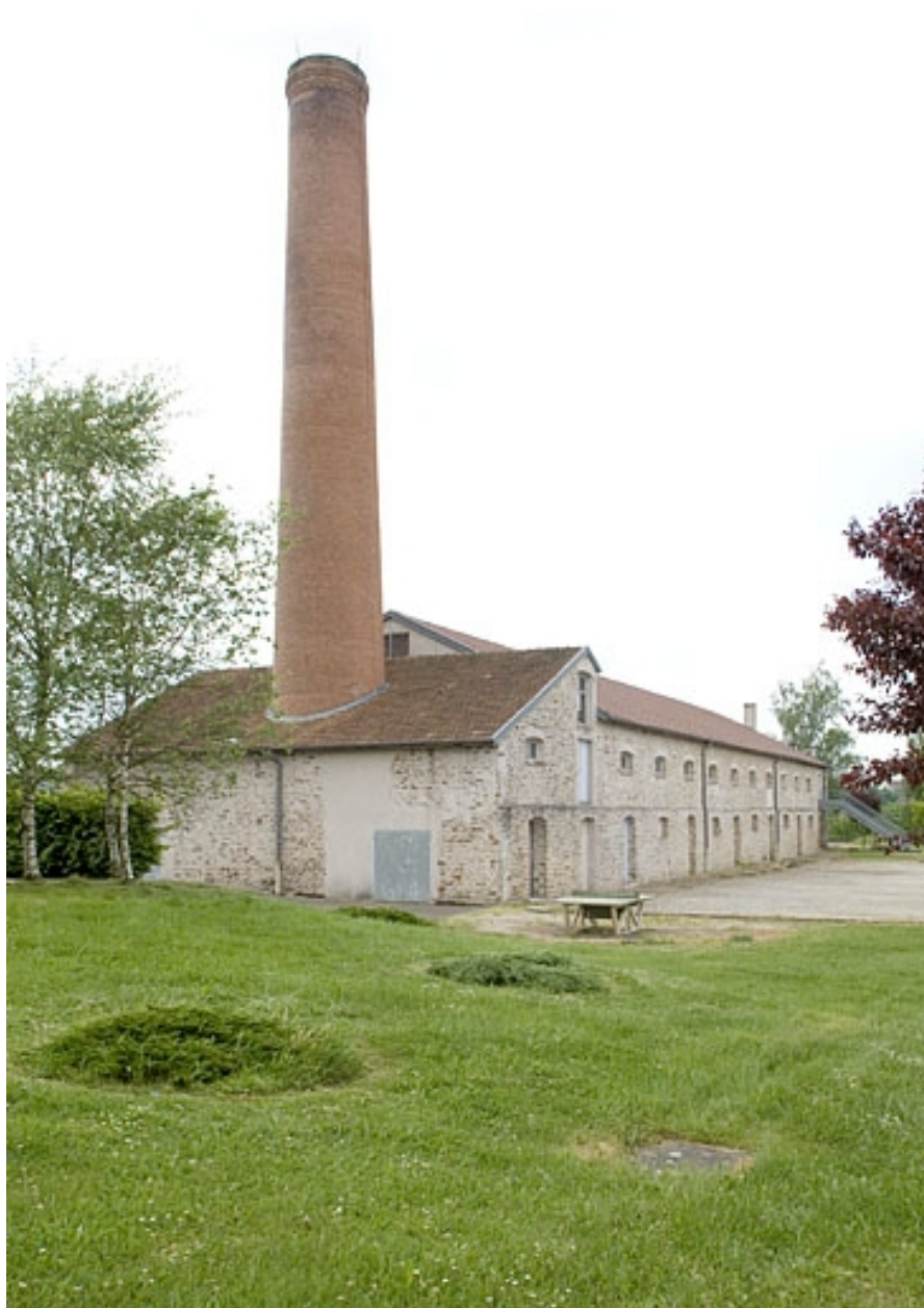
Vue de trois quarts depuis le nord-est.
