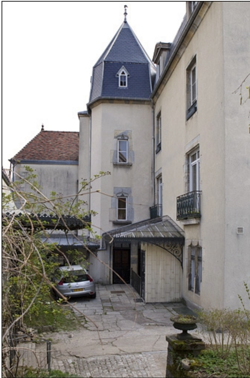
Logis principal : détail de la tour d'escalier.
