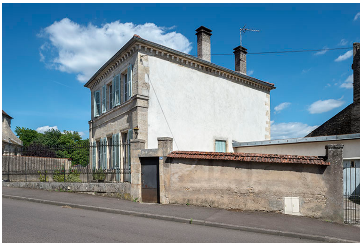
Le mur pignon sud-ouest.
