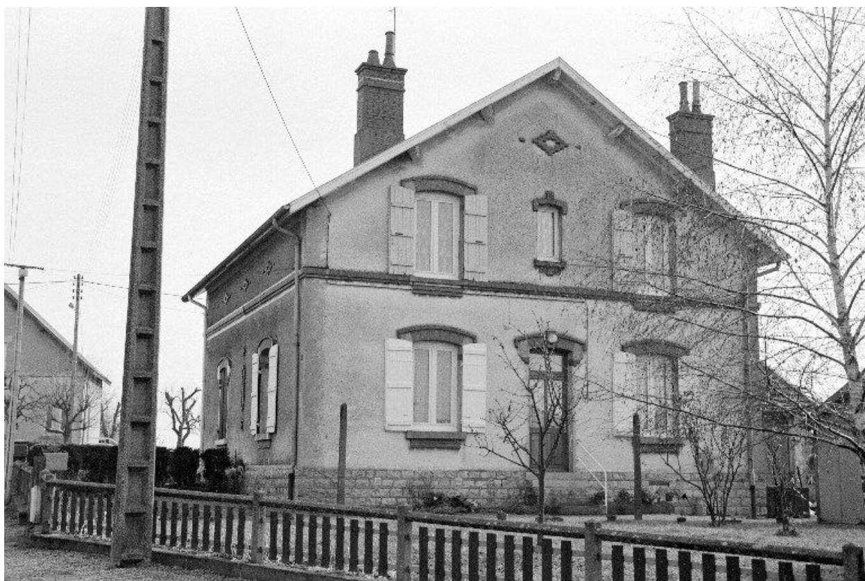
Bâtiment à 2 logements ouvriers de " type 3bis " au 10 rue Poincaré.
