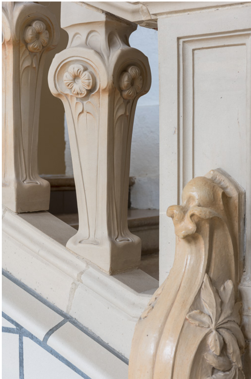
Hall des sources, rampe du degré, détail.
