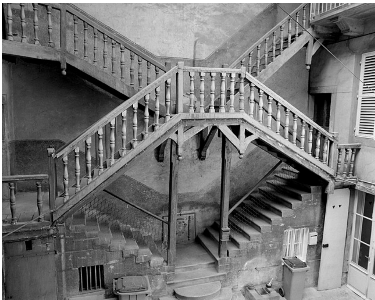
Maison, 17 rue Saint-Désiré, escalier sur cour.
