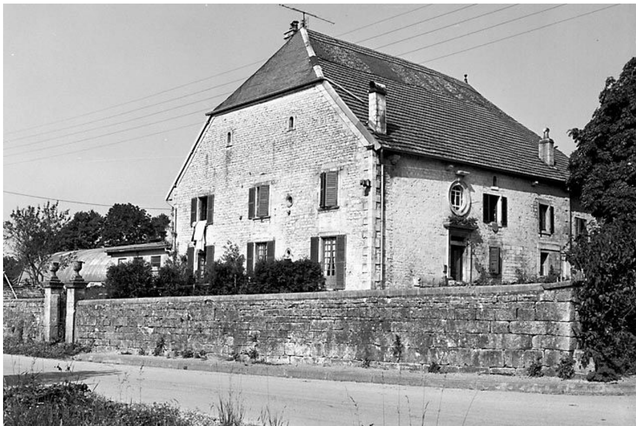
Ferme située rue du Château d'Eau.
