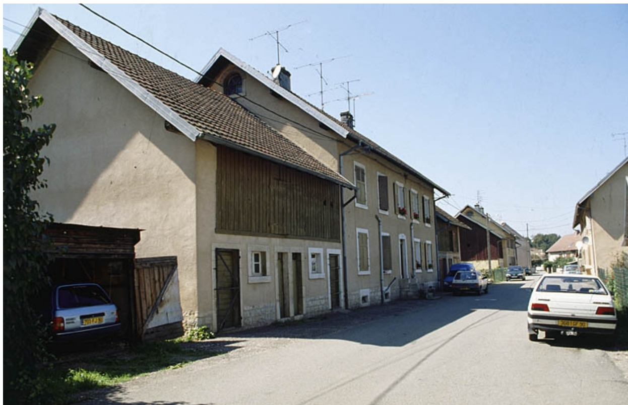
Logements ouvriers collectifs avec dépendances.
