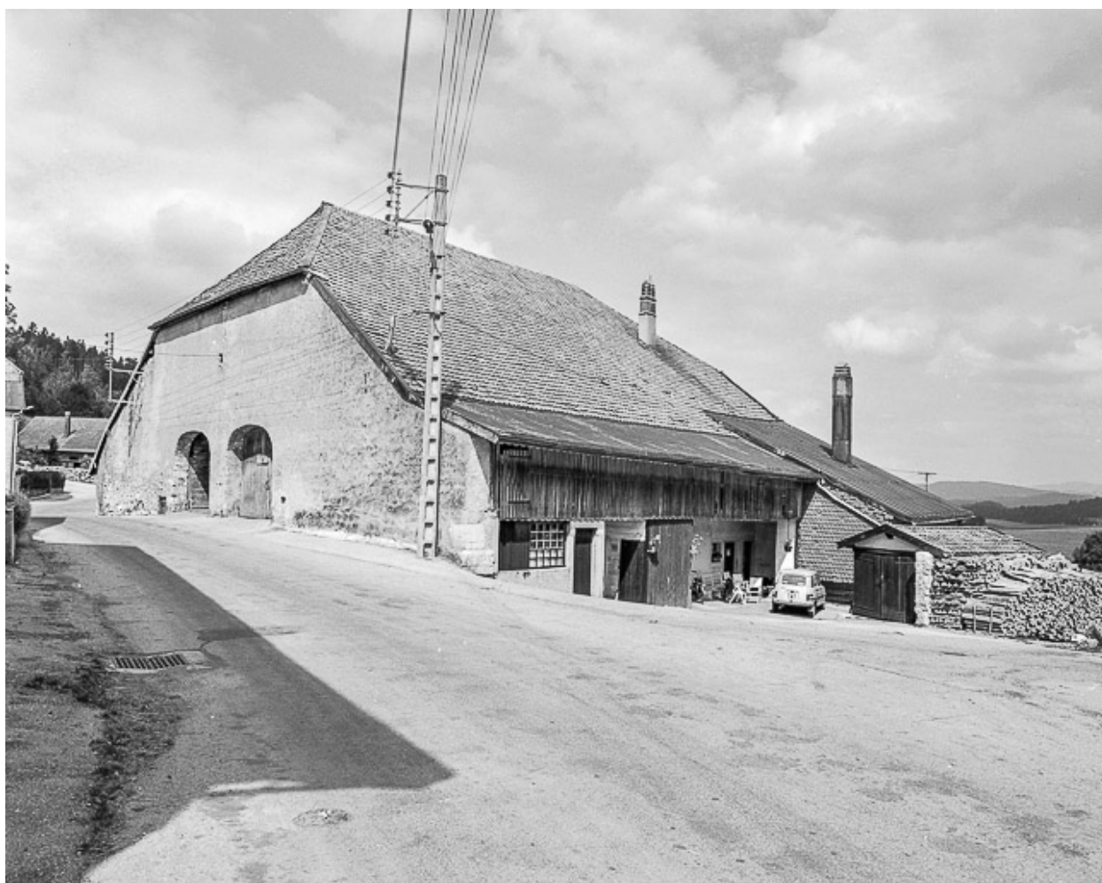
Pignon sur rue et goutterot.
