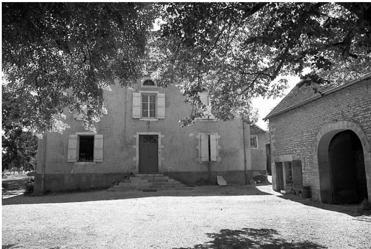
Vue des bâtiments depuis la cour.
