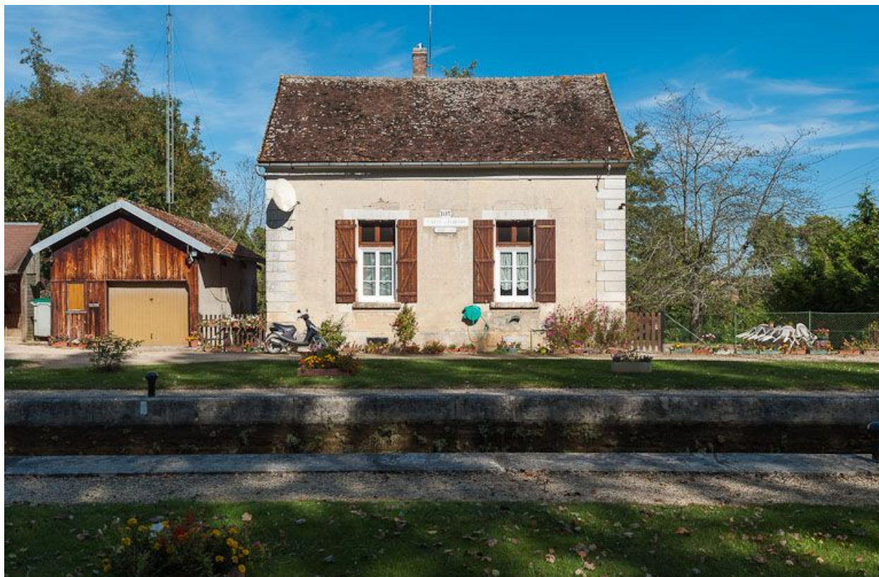
Maison éclusière de face avec son annexe.
