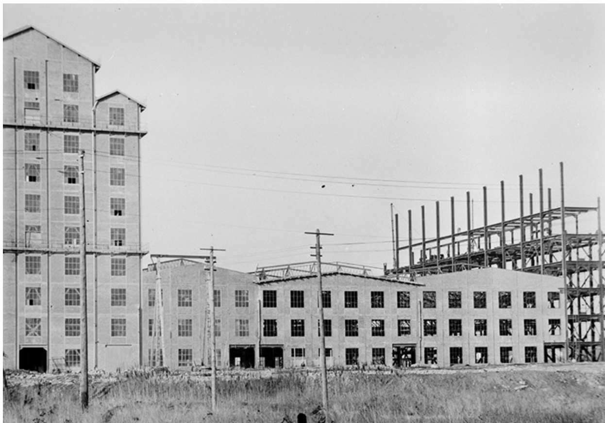
Soudière en construction, en 1930.
