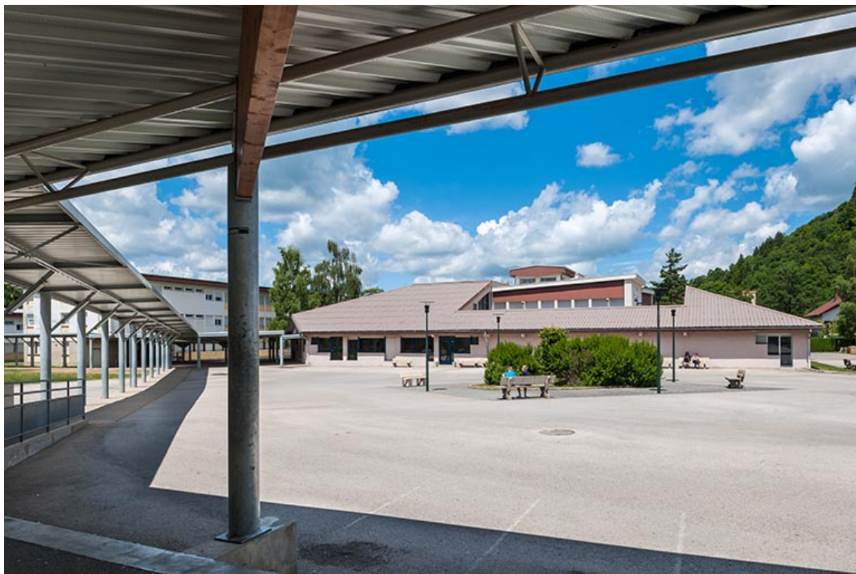
Restauration : vue d'ensemble, extension et bâtiment initial.
