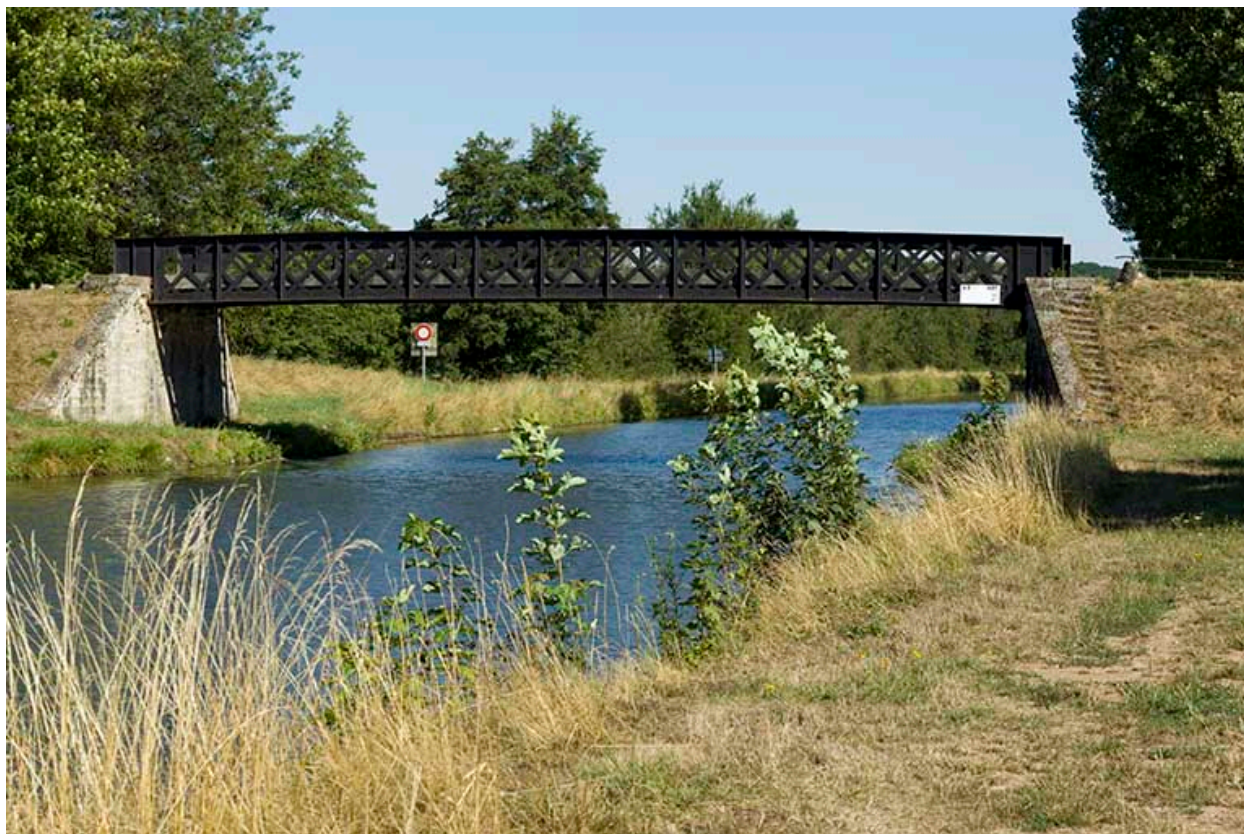
Pont du Devez, bief d'Ormoy (70).
