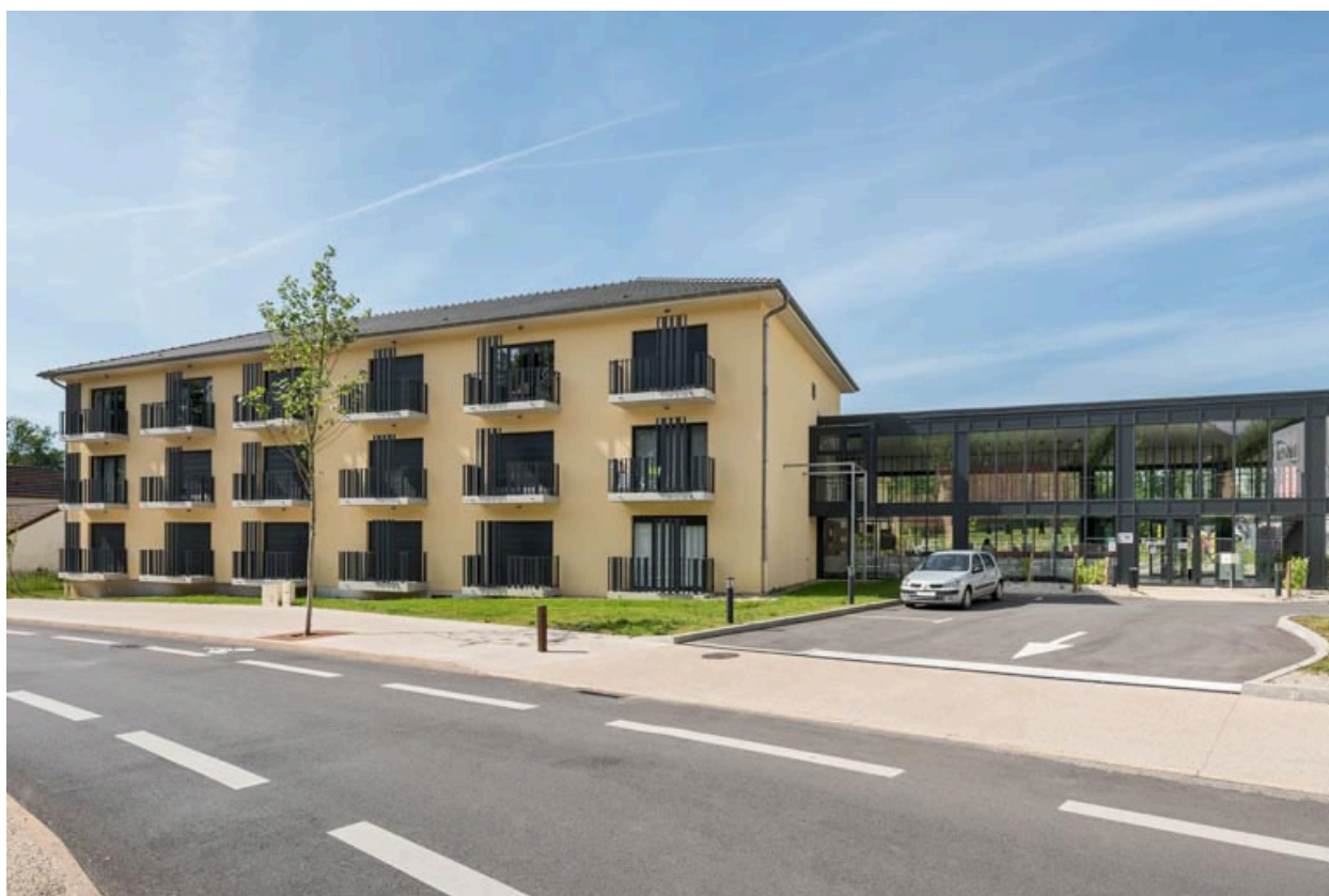
Vue depuis le nord-est : le hall d'entrée (à droite) et l'hôtel (à gauche).
