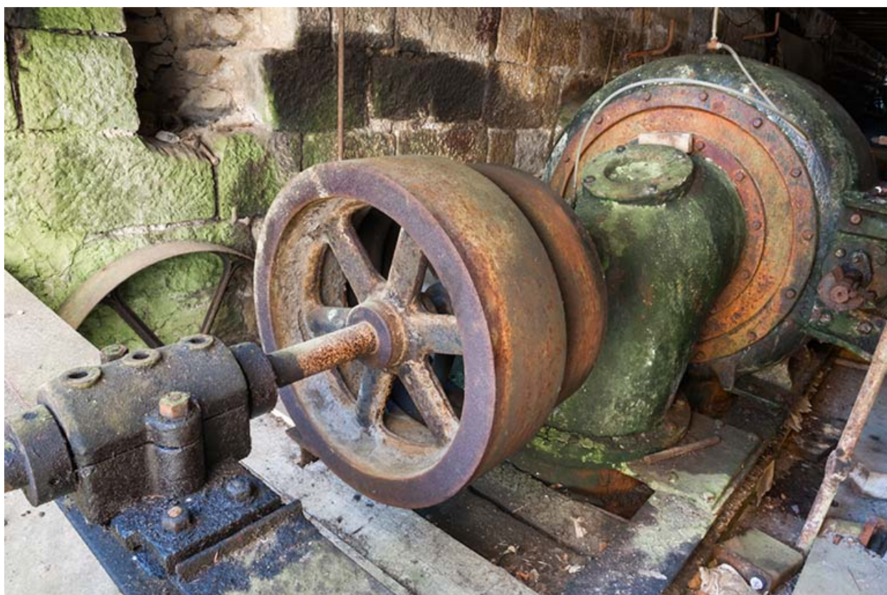
Turbine hydraulique (partie supérieure).
