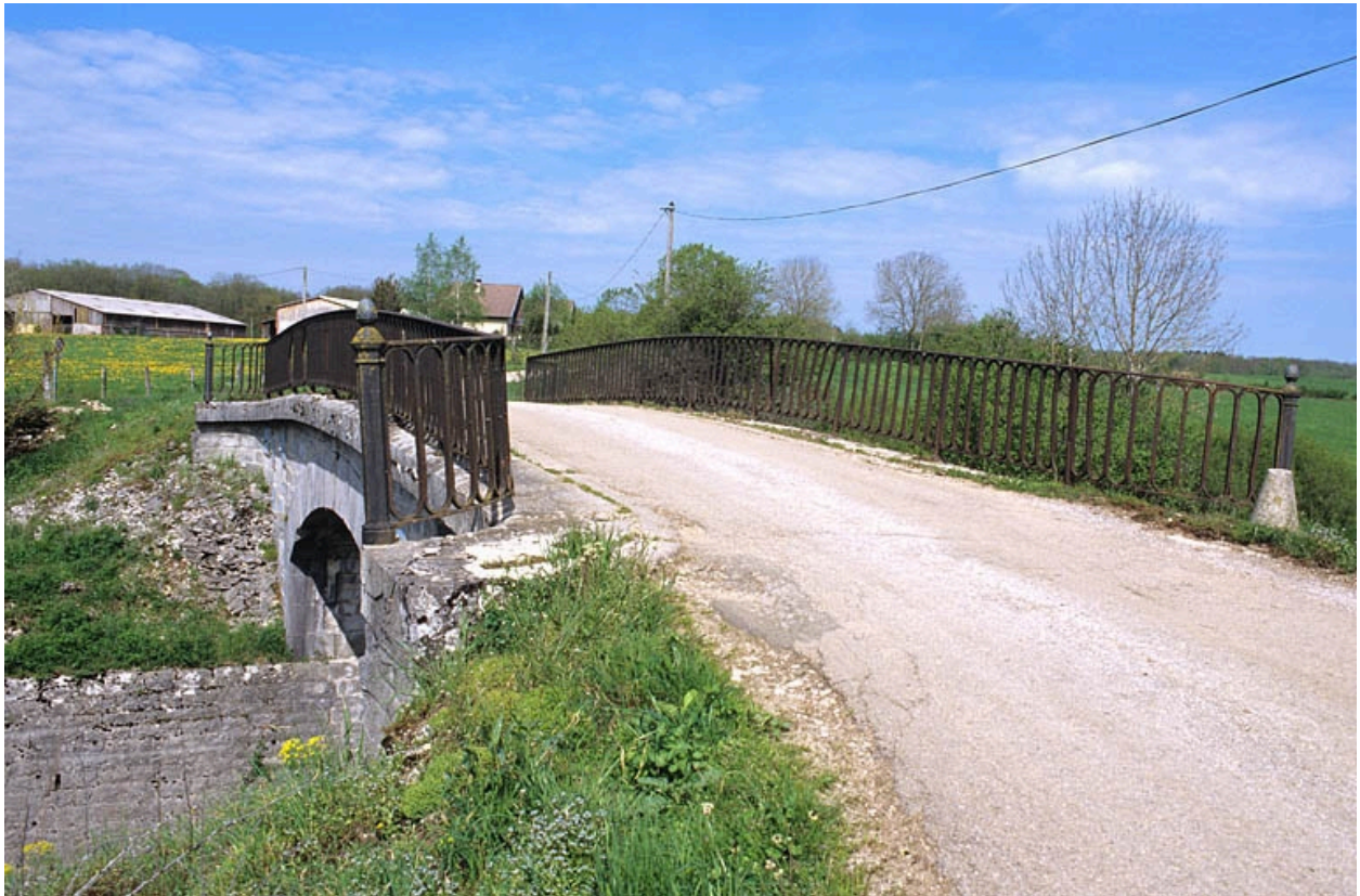
Tablier et garde-corps, depuis le nord-ouest.
