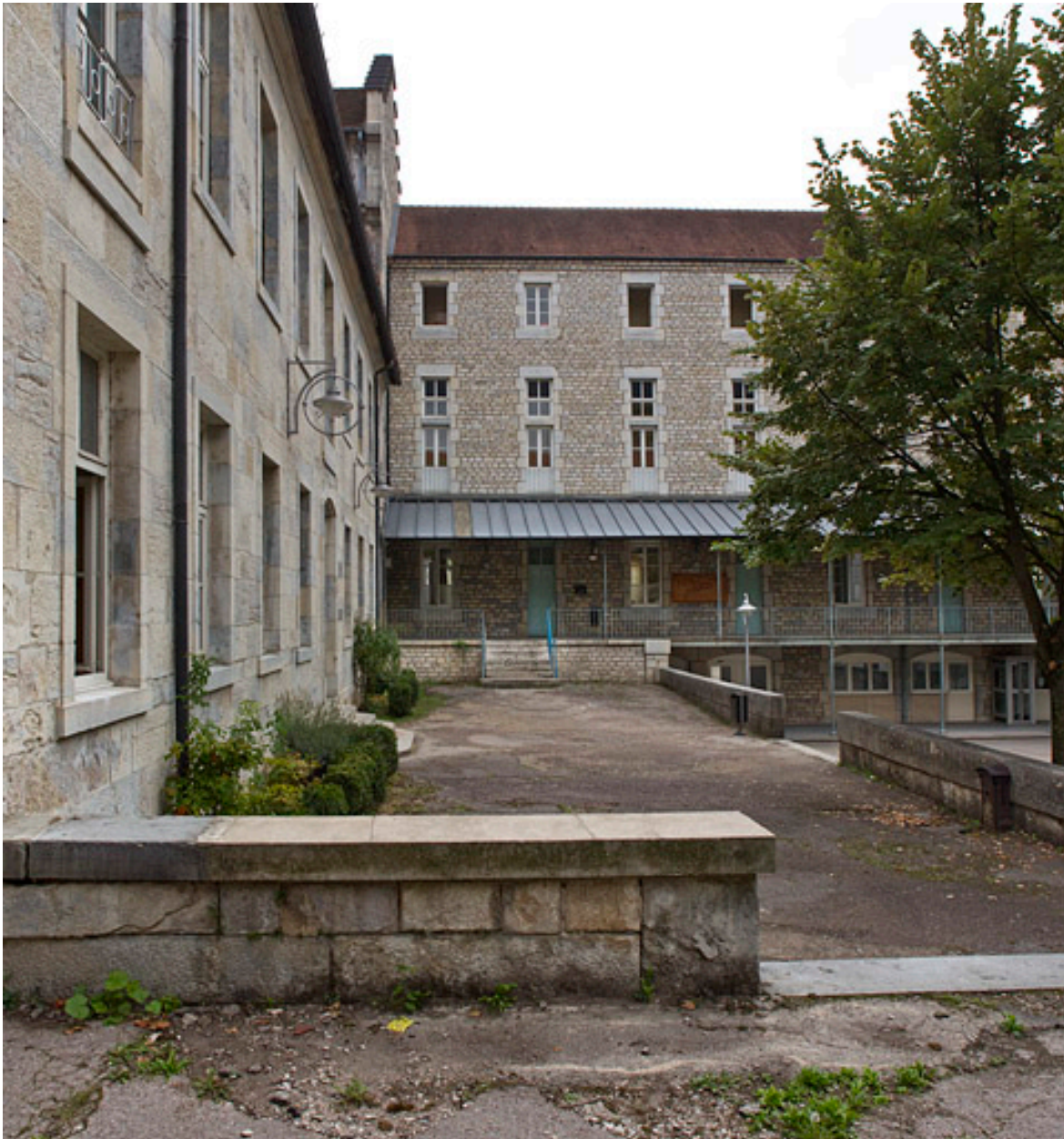
Vue de la façade antérieure du bâtiment Girod de Chantrans.
