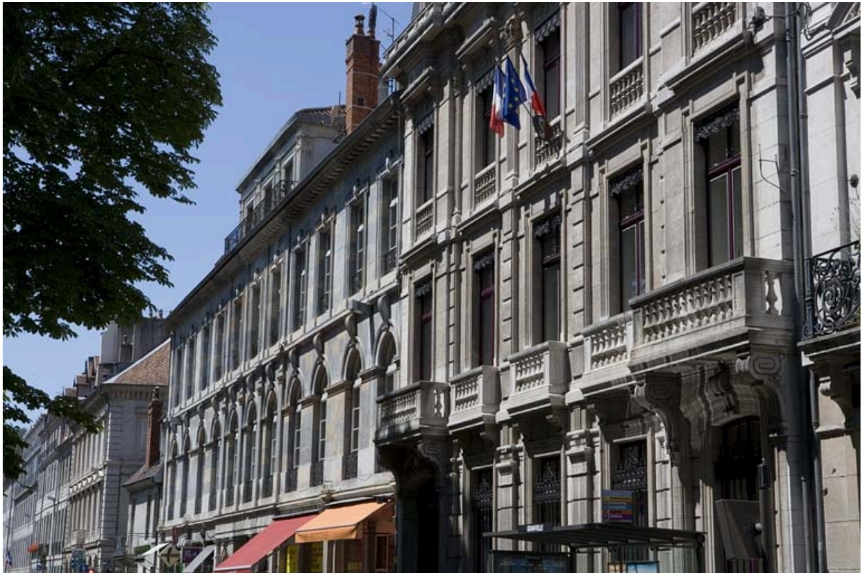
Détail de la façade sur rue, de trois quarts droit.
