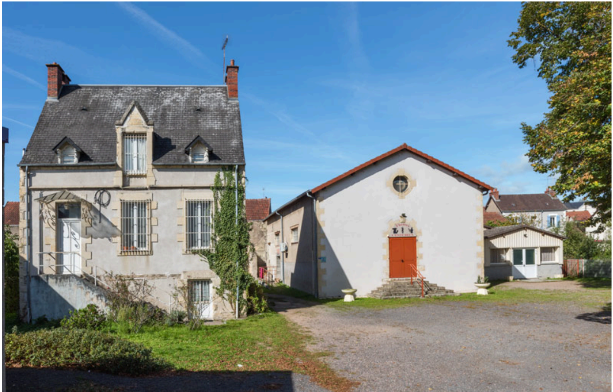
Vue d'ensemble, depuis le sud. A gauche, l'ancien presbytère.
