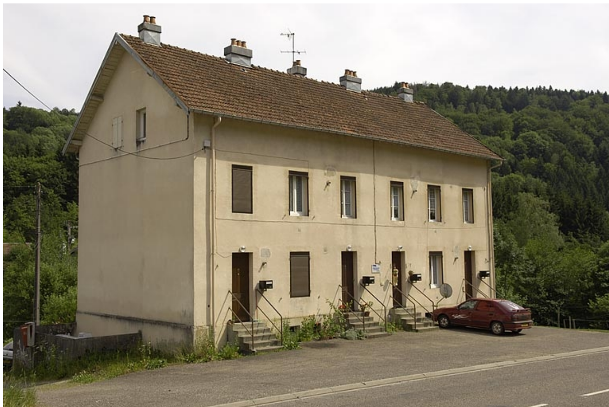
Logement ouvrier collectif.
