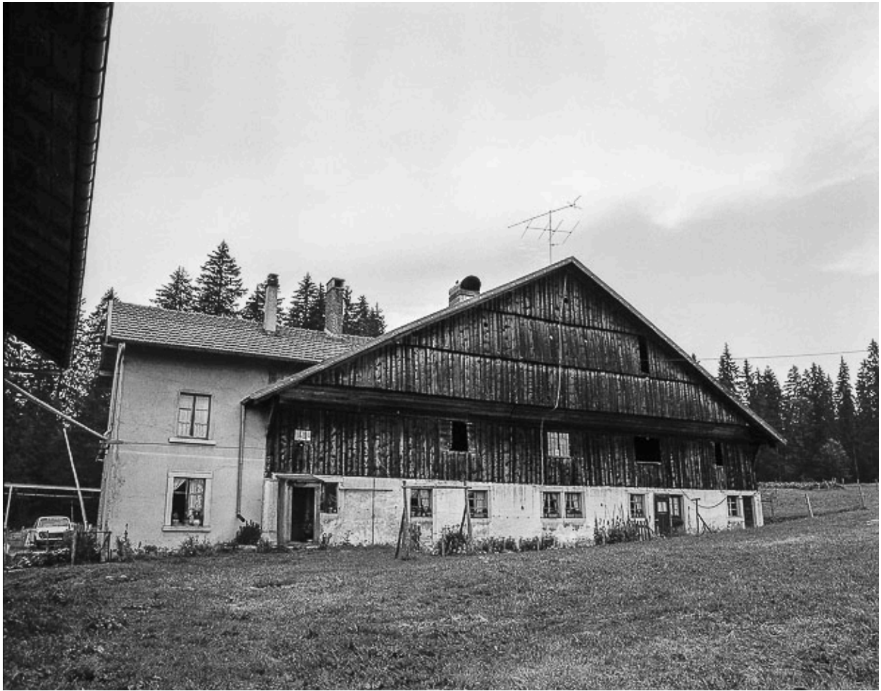
Ferme située au lieudit Meix Lagor, cadastrée 1966 F2 69 : façade antérieure.
