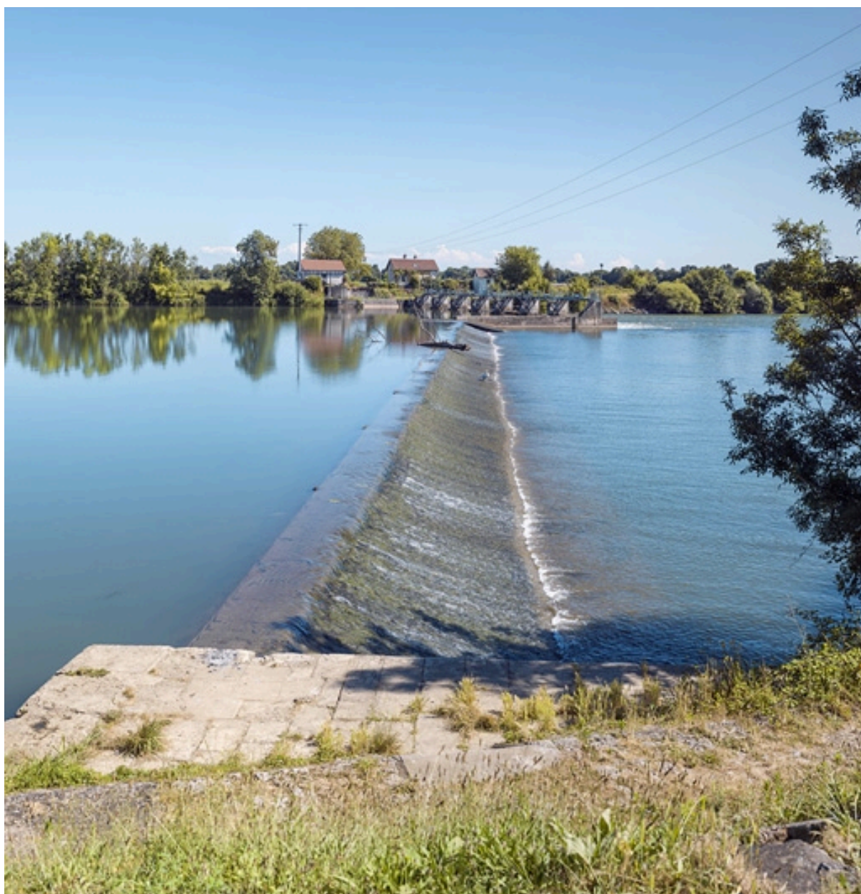
Le déversoir du barrage.
