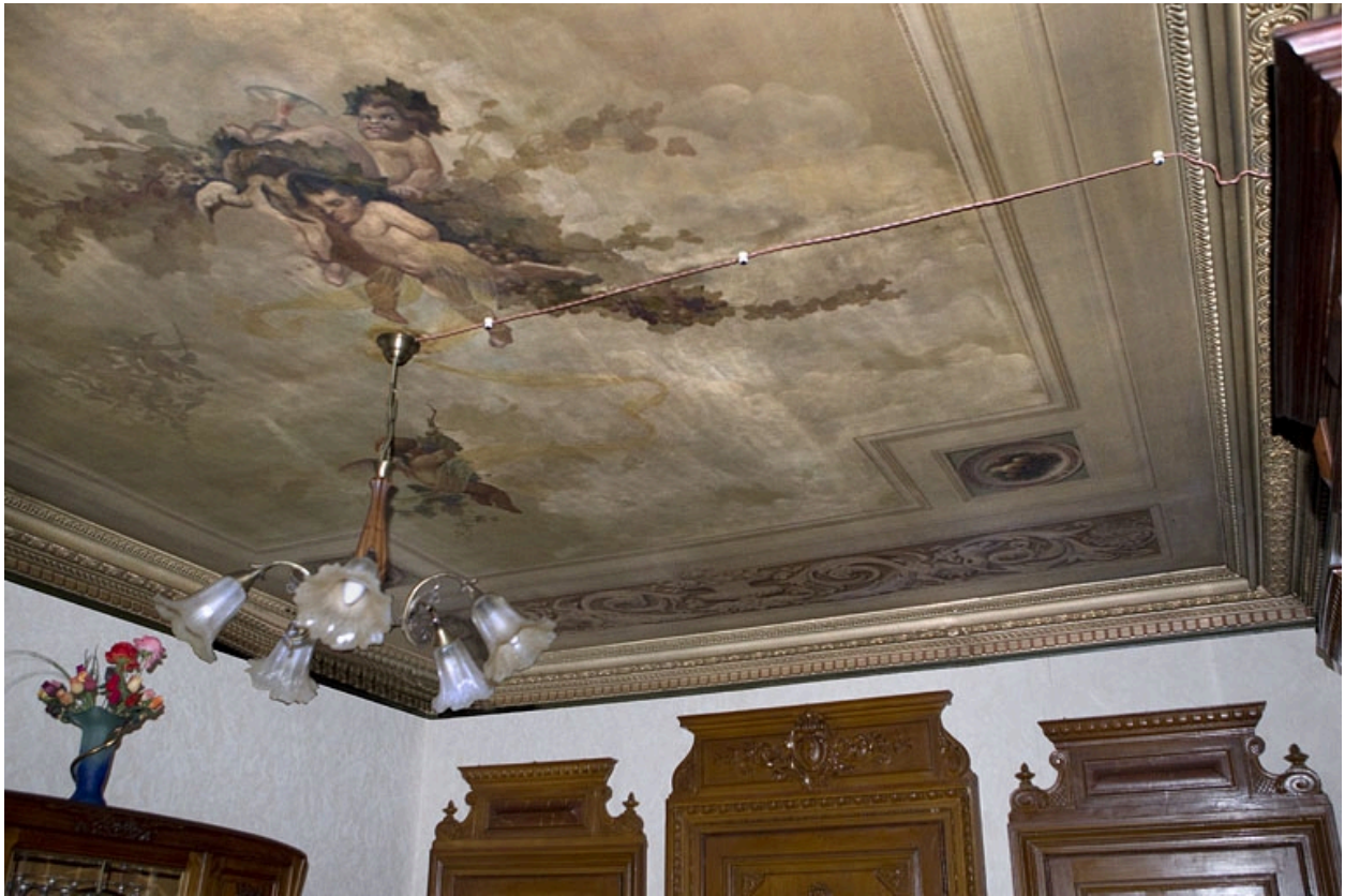
Salon : vue d'ensemble du plafond.
