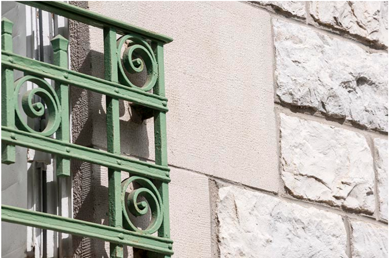
Façade latérale gauche : détail de l'appareillage du mur, de l'encadrement de fenêtre en béton et de la ferronnerie.
