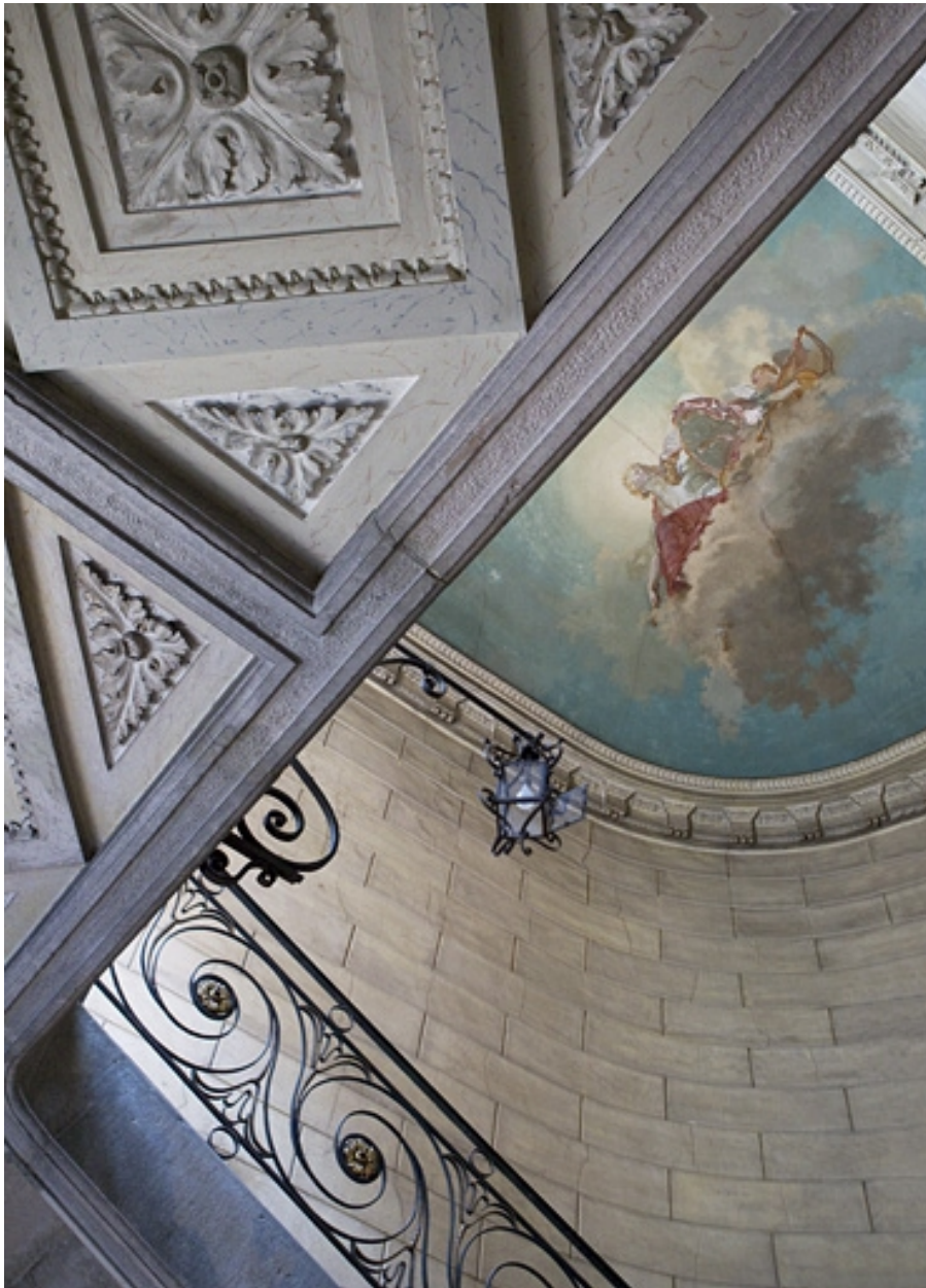
Intérieur : détail du plafond de la cage d'escalier.
