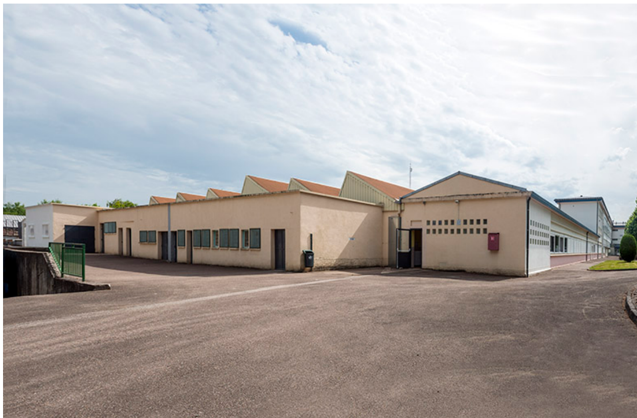
Ateliers : façade latérale.
