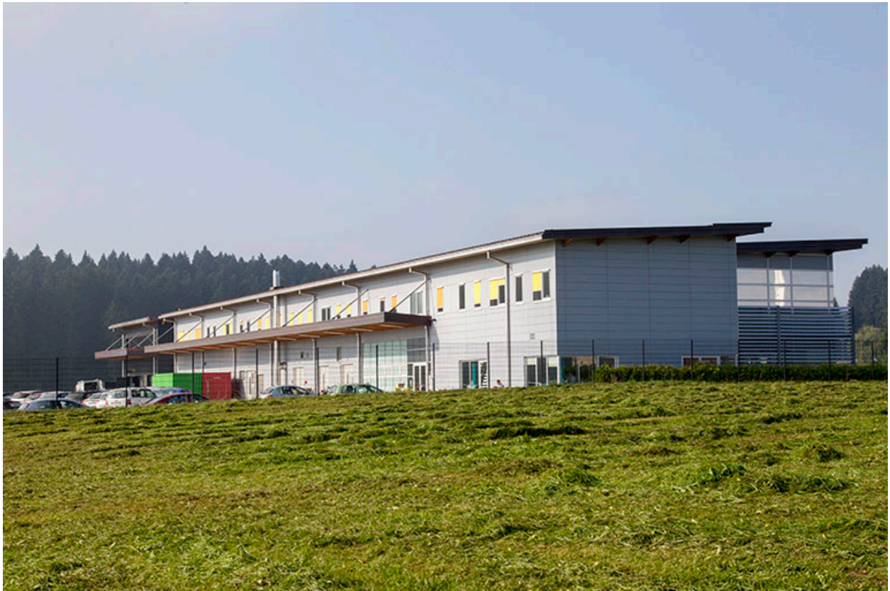
Façades antérieure et latérale droite.
