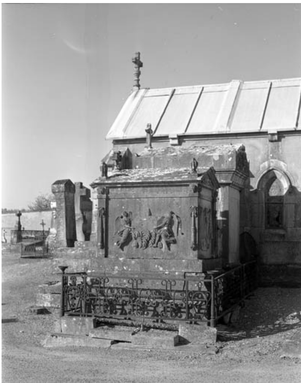
Façade latérale gauche.
