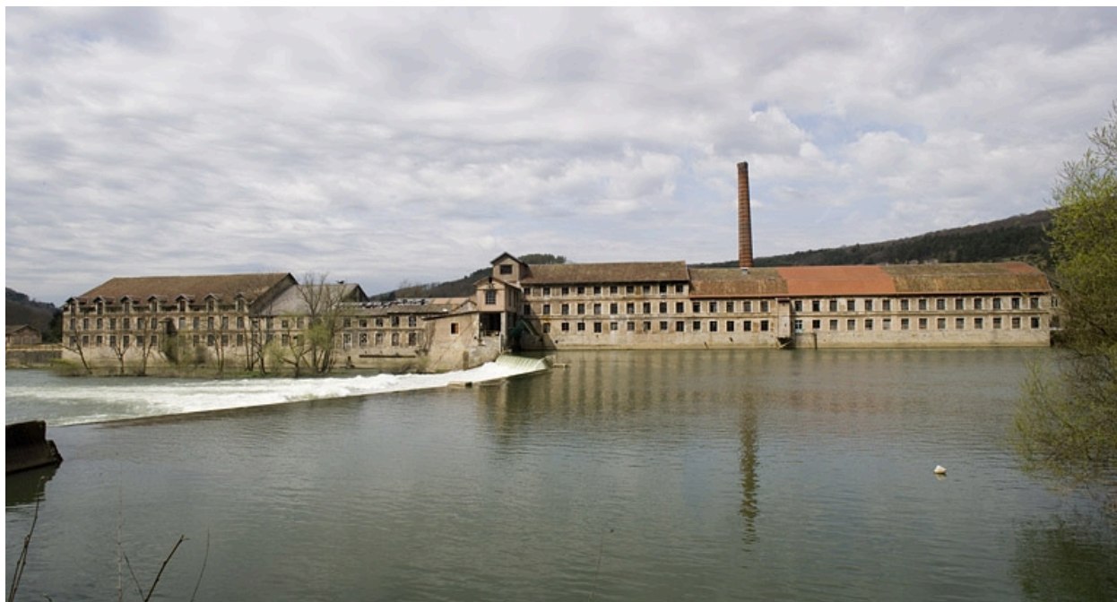
Vue d'ensemble de la papeterie depuis la rive gauche du Doubs.
