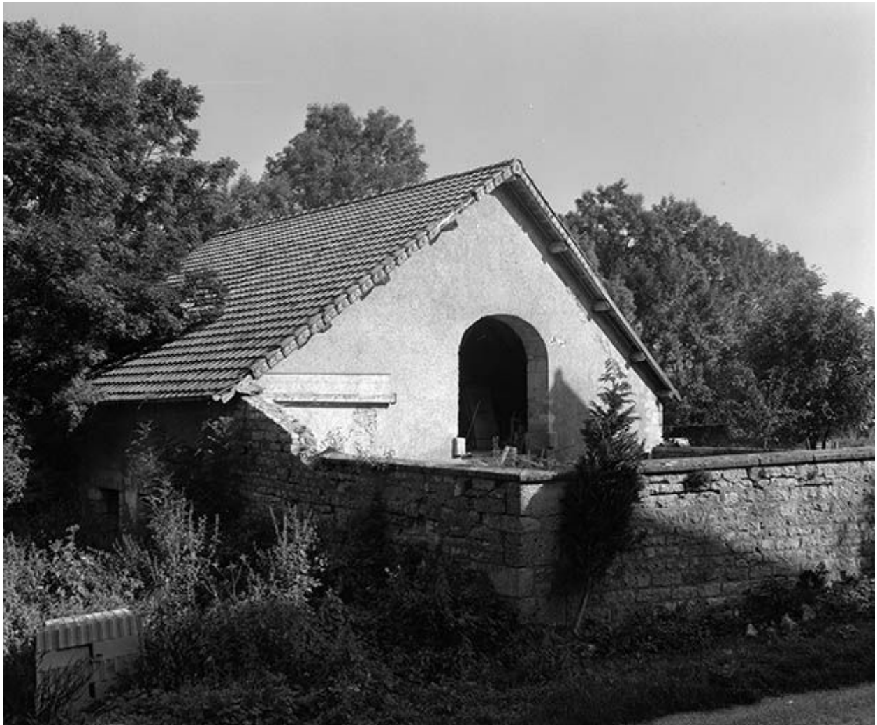
Façade antérieure des parties agricoles.
