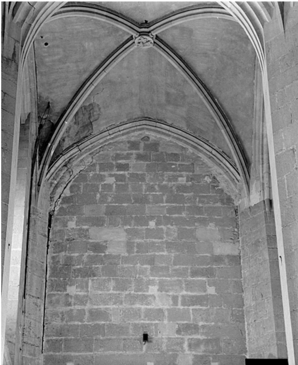
Voûte de la huitième travée du collatéral nord et mur de fermeture de l'ancienne chapelle de Neuville.
